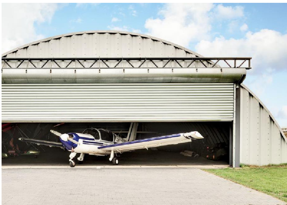
R1 SSP KAPU EGYFALÚ ACÉL PROFILOKKAL tartóssága miatt nagyon széles szerkezetek létrehozását teszi lehetővé
